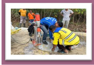
Pengujian/ Pengambilan Sampel Uji (Core Drill) Beton Inti
