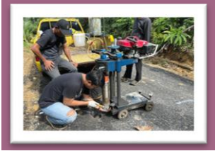
Pengujian / Pengambilan Sampel Uji (Core Drill) Lapis Beraspal
